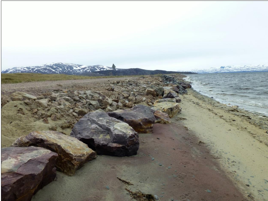
Bildet viser vegfyllingen, med de store steinene ytterst, etter at kommunen utbedret vegen våren 2016. Foto: B. Christiansen
