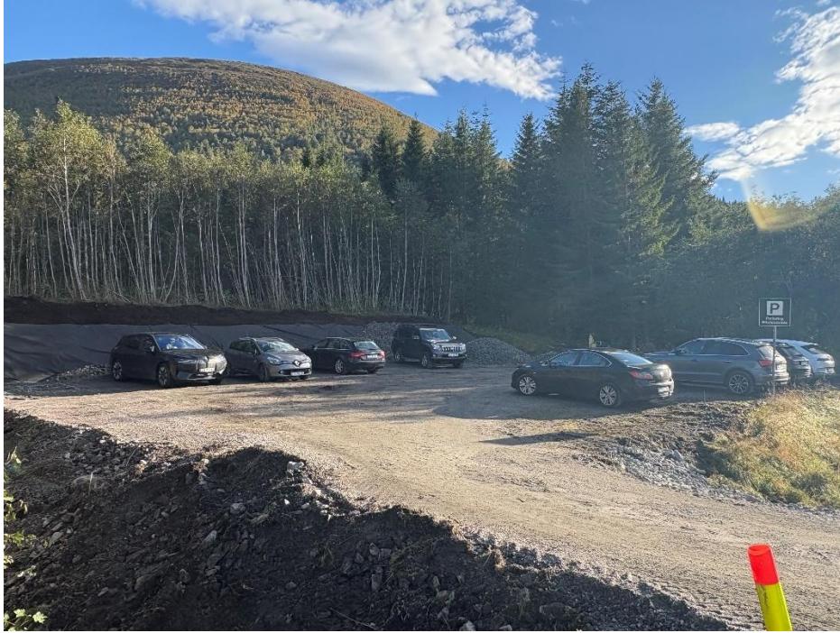
Figur 3. Arbeidet med utviding av p-plassen ved Trohaugen er snart sluttført.
